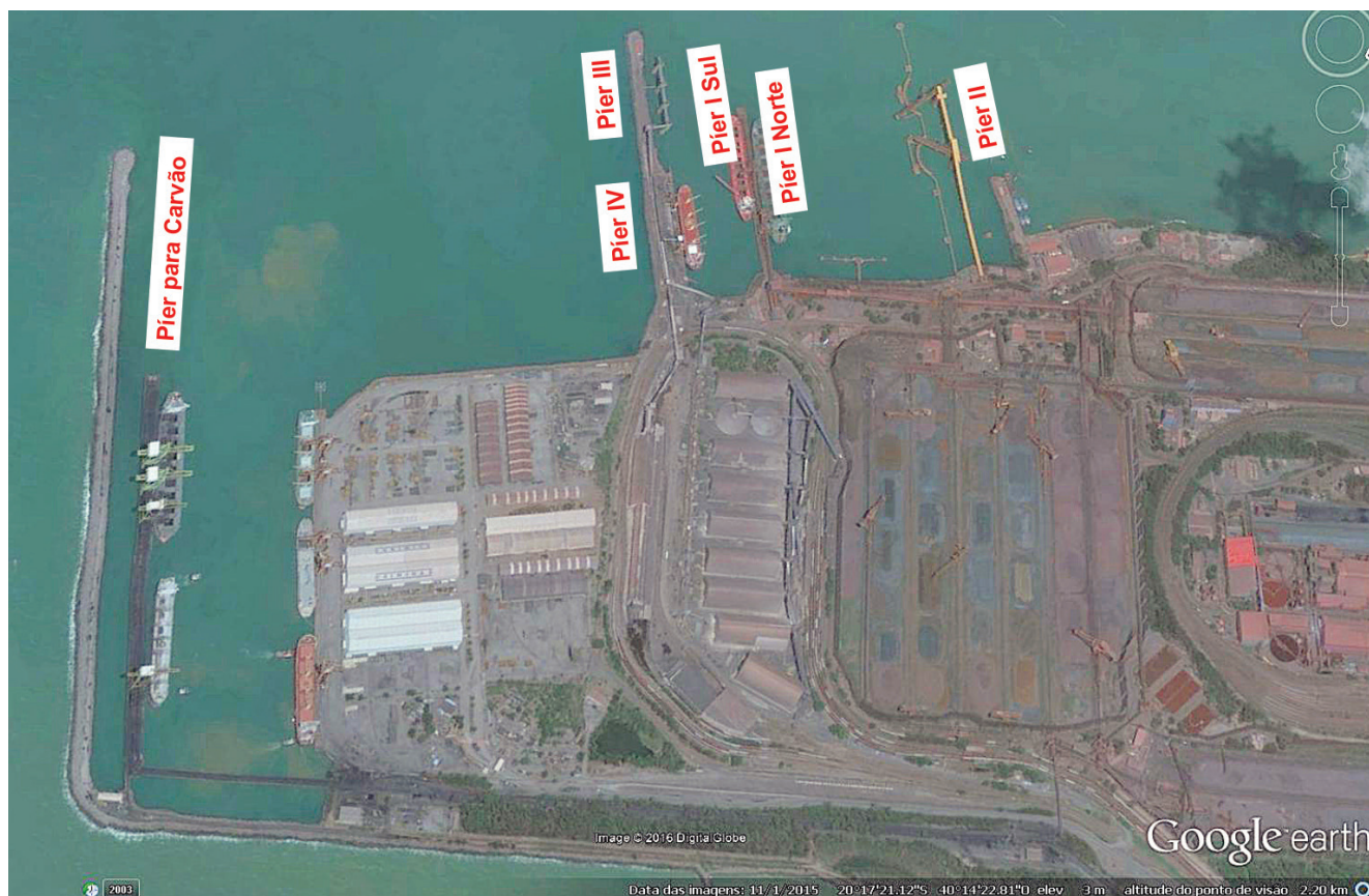
Figura 1: Vista geral do Porto de Tubarão e identificação dos berços
