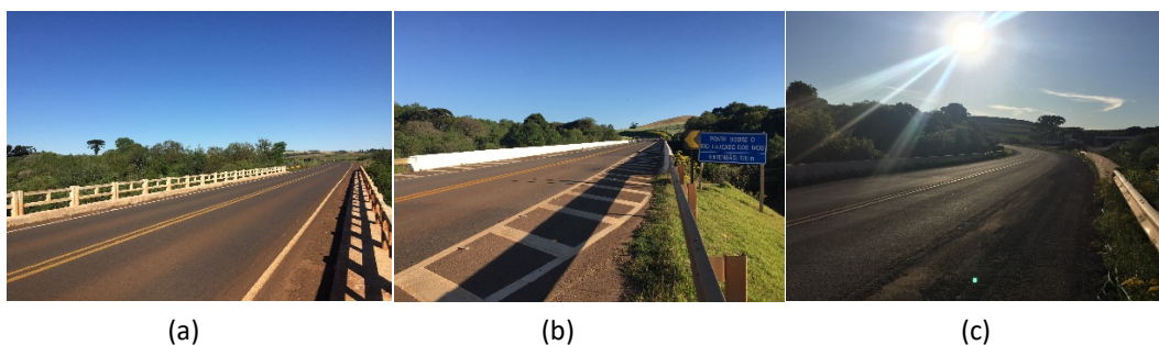
Figura 2: Obras de arte avaliadas: a) Ponte 1; b) Ponte 2 e, c) Ponte 3.
