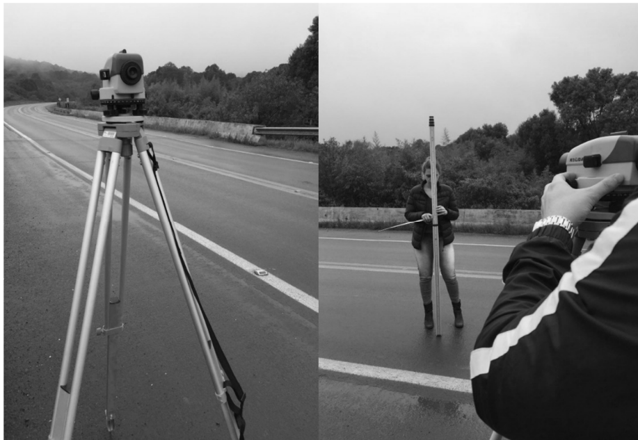
Figura 5: Execução do Método de Nível e Mira na Ponte 3.
