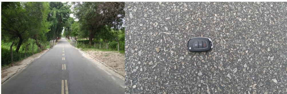
Figura 5. Vista geral do trecho para calibração e detalhe do revestimento.
