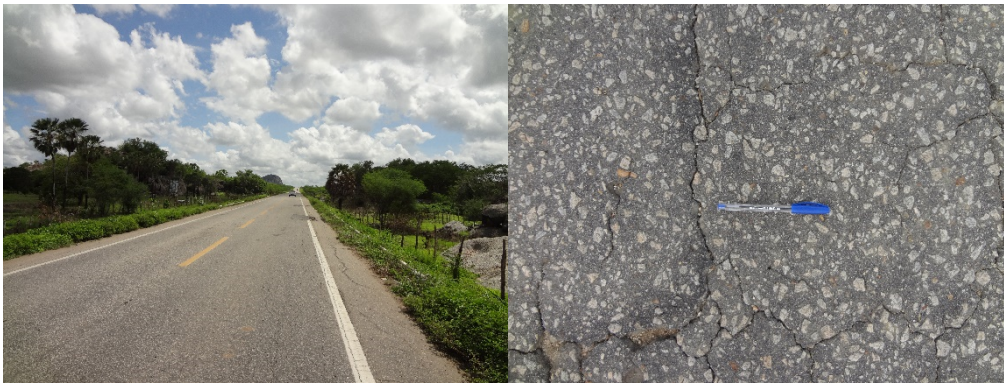
Figura 10: Vista geral do trecho e detalhe da textura (QXD-PIR)
